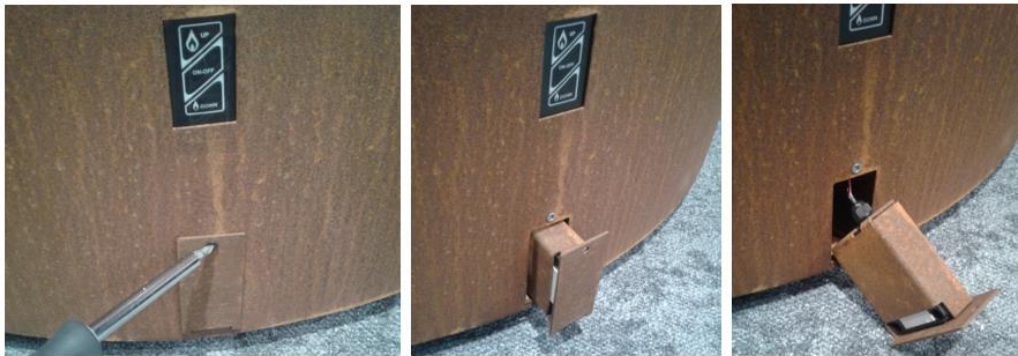
Foto 6: Herausnahme des Batteriebehälters
